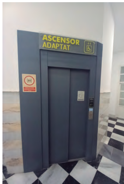
El ascensor del Ayuntamiento reúne las características mínimas para personas con discapacidad.
