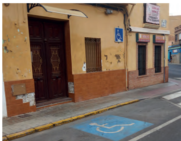
Es necesaria la correcta señalización vertical y horizontal de la plazas y una pintura clara antideslizante y con la señal actualizada de la discapacidad.
