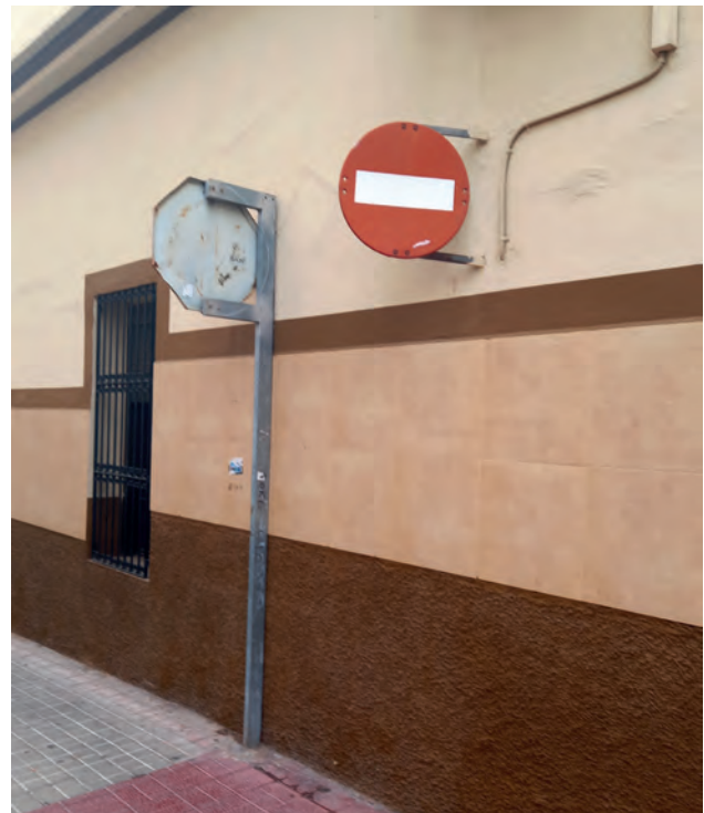
Los postes que soportan señales de tráfico no deben ubicarse en itinerarios para no ser un obstáculo ni un peligro.
