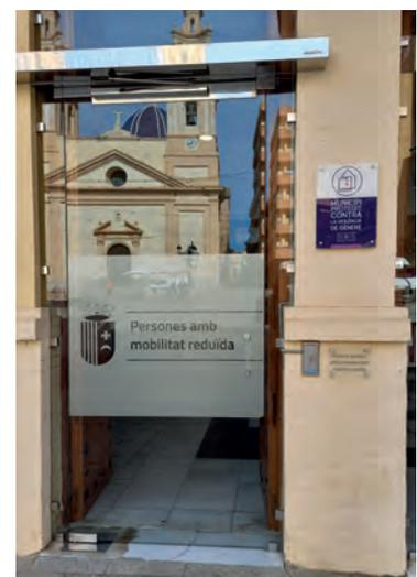
Opciones alternativas posibles: Pueden ser puertas de apertura fotoeléctrica o con mecanismos integrados de apertura automática por botón. Las puertas de cristal deben estar en todo momento señalizadas
