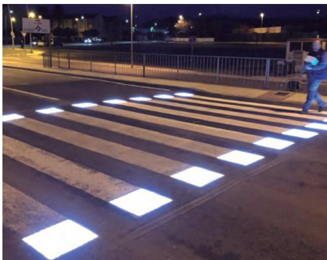
*Paso peatonal con luces led laterales para aumentar la visibilidad a los conductores y la seguridad a todos los peatones.*
