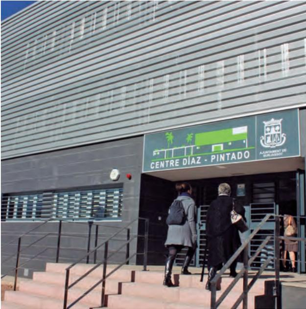
*Los accesos han de garantizarse teniendo en cuenta la posibilidad de una rampa lateral, protección de los escalones para evitar resbalones, la doble barandilla y la puerta fotoeléctrica de apertura automática y señalizada*
