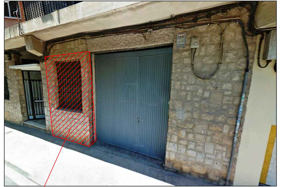
AMPLIACIÓN HUECO PUERTA
