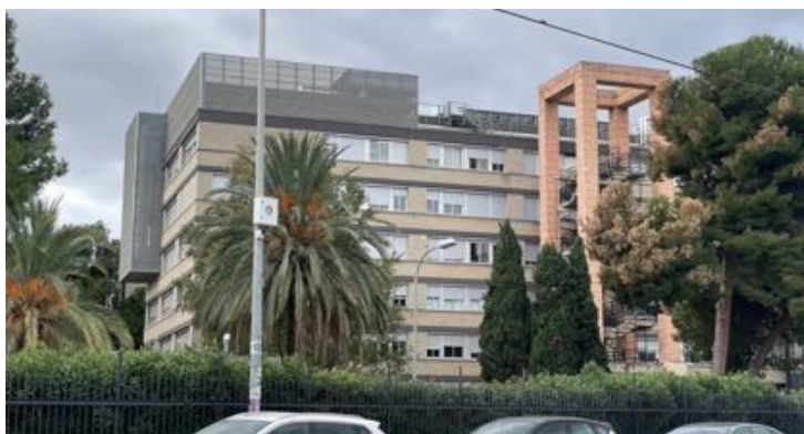
Plantas técnicas sobre edificios universitarios del Campus.
