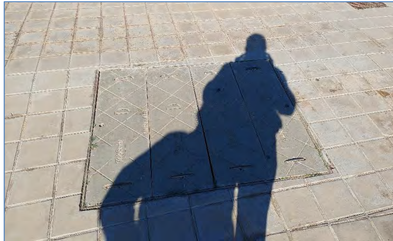
Foto 6: Arqueta de telefonía existente en esquina de calles rector Francisco Tomás y catedrático Escardino
