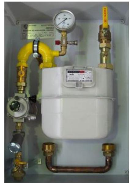
Dada la recomendación recogida en la UNE 60670 donde se dispone que el caudal máximo en condiciones de línea esté en torno al 60% del caudal nominal del contador se instalará un contador de medida G-40 (65 m<sup>3</sup>/h) garantizando que cuenta en consumo mínimo generado por un solo aparato (0,40 m<sup>3</sup>/h).
